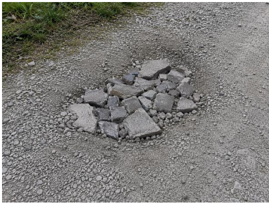
Gambar 1. 4 Proses Penghancuran dan Pemanfaatan sebagai Urukan Jalan]
