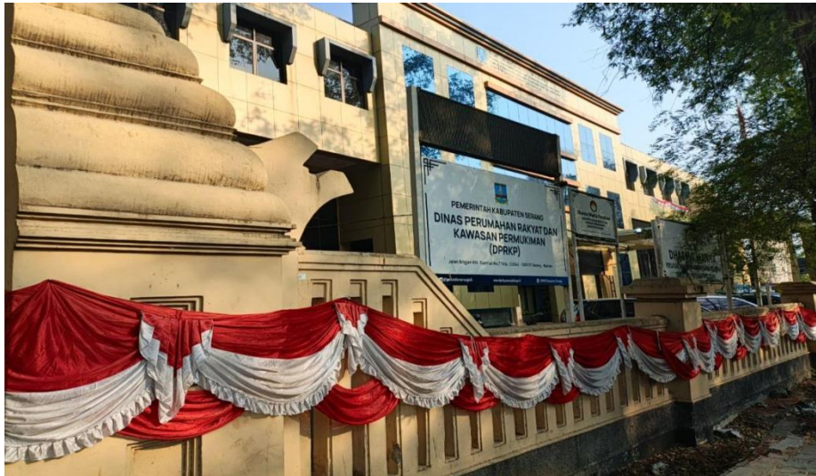
Gambar 1. Gedung Dinas Perumahan Rakyat dan Kawasan Permukiman Kabupaten Serang
